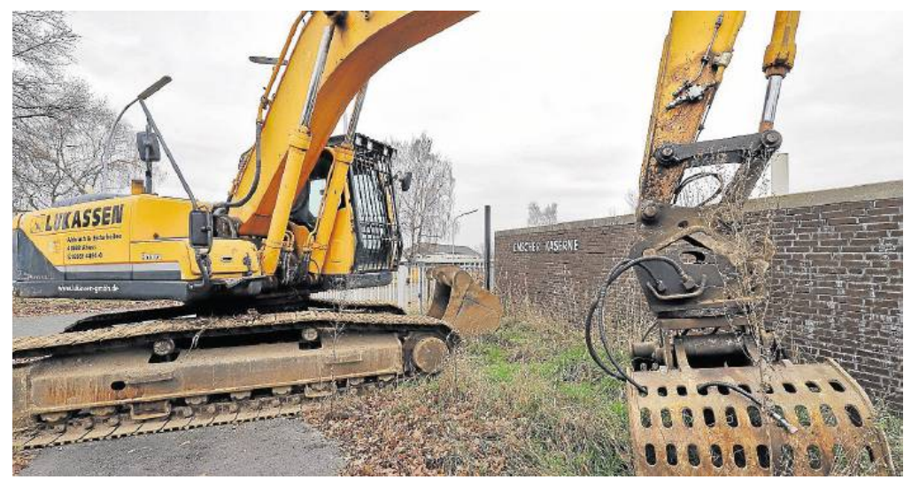
Für den Abbruch wird schweres Gerät benötigt.
